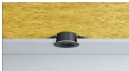
Bedekking met opgerolde isolatie
